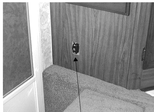
Aux. Battery Switch
